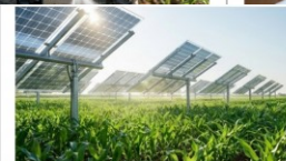
Systèmes agrivoltaiques dynamiques (SAD) suivant le cours du soleil. Création de microclimats contrôlés et crépus. Création de microclimats contrôlés qui protègent les cultures du stress thermique, de l'évaporation et du gel.
